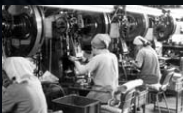
昭和30年後半に使用されていたプレス機（動力式）
